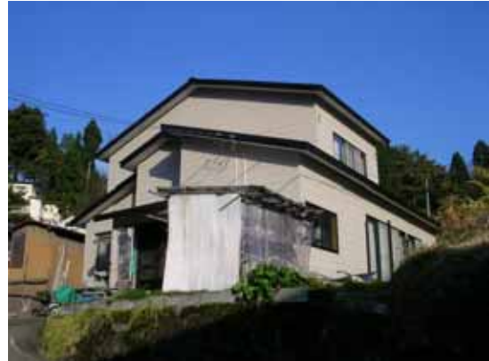
写真 4.2.18 蓬平 住宅 D 外観上殆ど損 傷のない住宅
