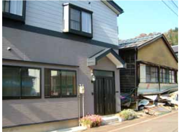
写真 4.3.10 川口町 医院 新築と推測さ れる。窯業系サイディングに外観上の被害 は見受けられない。
