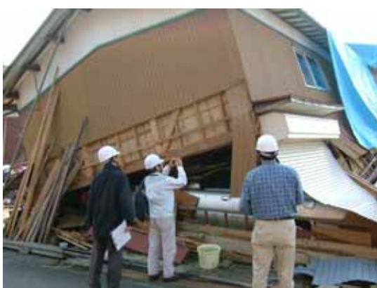
写真 4.1.2 小千谷市桜町の倒壊住宅
