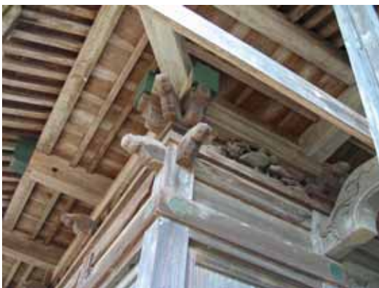
写真 4.2.11 濁沢 伝統の木組みは、びくともしていない。
