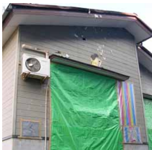
写真 4.2.3 爆風が吹き付けられた共同住宅Aの隣家
