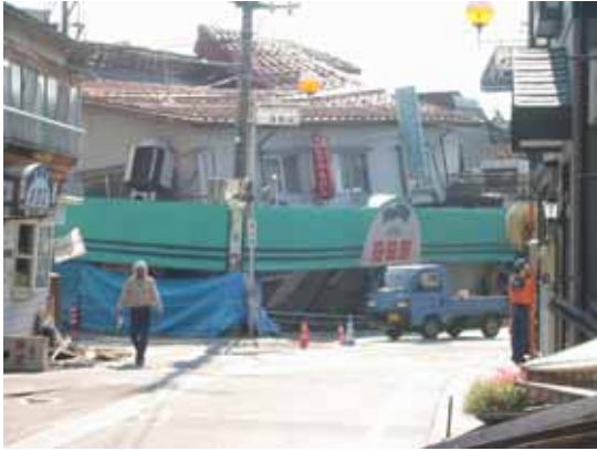
写真 4.2.33 川口町 越後川口駅前通 間口の大きな店舗は1階部分が完全に崩壊。
