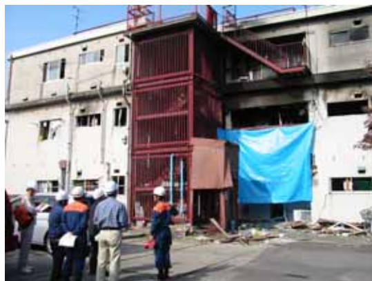
写真 4.2.1 長岡市千手 鉄骨造3階建て共同住宅A (外壁ラスモルタル、一部金属系サイディング) ガス爆発事故現場外観
