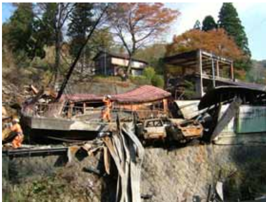
写真 4.2.5 濁沢 火災現場B
