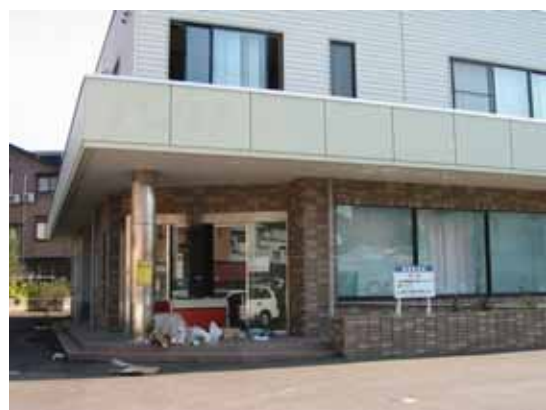
写真 4.2.38 川口町 越後川口駅前通 S造と思われる要注意表示建物
