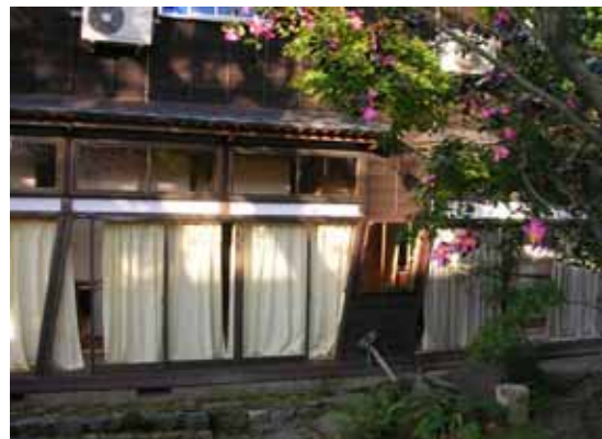
写真 4.2.20 六日市町 伝統的構法の住宅 J(布基礎) 昭和50年頃築 南面に殆ど壁のない家で、垂れ壁も採光窓 になっている。
