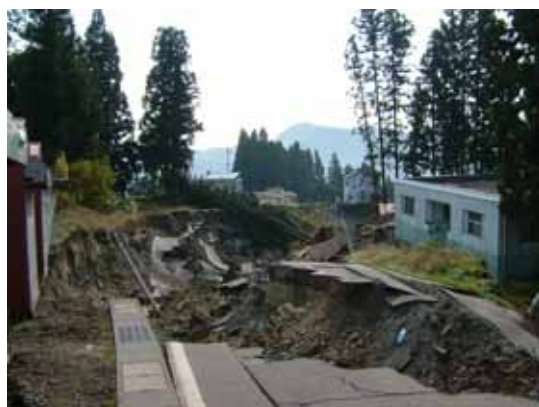
写真 4.1.5 小千谷市の地滑り現場
