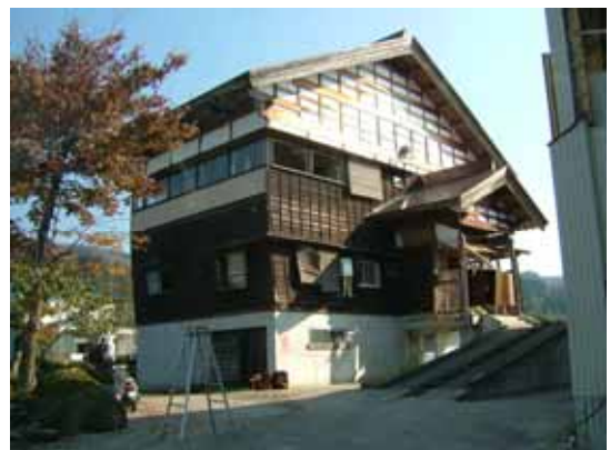
写真 4.2.32 川口町 半壊の高床式住宅 基礎は無傷でも上部構造1階部分は傾いている。
