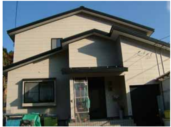
写真 4.3.5 蓬平町 住宅 D(窯業系サイディング 釘留め工法) 外観上大きな損傷なし
