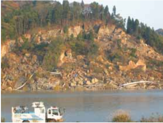
写真 4.1.7 長岡市妙見町の土砂崩れ現場
