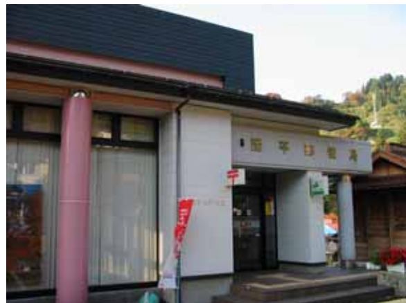
写真 4.3.7 蓬平町 郵便局(木造) (窯業系サイディング 釘留め工法) 外観上大きな損傷なし
