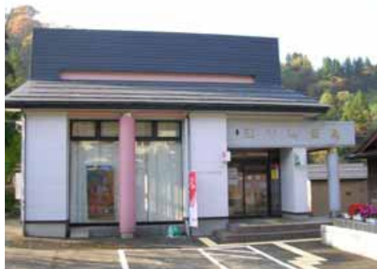
写真 4.2.14 蓬平 郵便局 外観に殆ど損傷はない様に見える。
