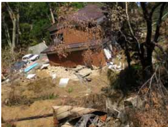
写真 4.2.6 濁沢 火災現場Bに隣接した 地滑り 道路や車ごと数十メートル滑り落ちた家屋
