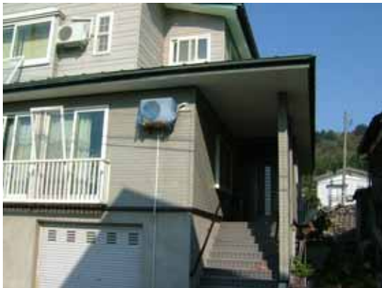
写真 4.3.9 川口町 住宅 E 築 5 年程度と 推測され、窯業系サイディングに外観上の 被害は見受けられない。
