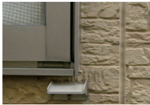
伝い水防止水切を設置した例
